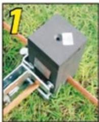
1 Posicione correctamente el molde, conductores y tenaza
