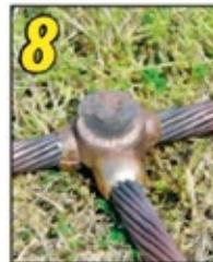
8 Retire el molde de soldadura y limpie antes de tomar la próxima conexión.
