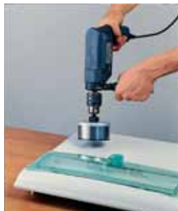
Taladrado de una tapa ciega para instalar una base de conexión fuera de estándar
