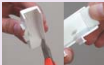
Remover o pré-corte do acoplador
