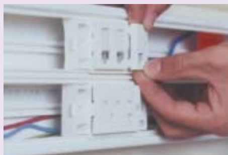
Instalação dos módulos Pialplus
