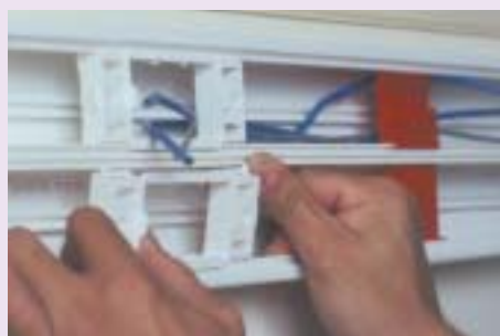
Passagem dos cabos e fixação do suporte
