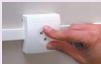
Encaixar a tampa à base do mecanismo
