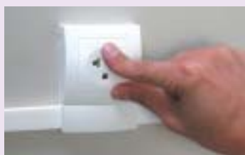
Encaixar a tampa à base do mecanismo
