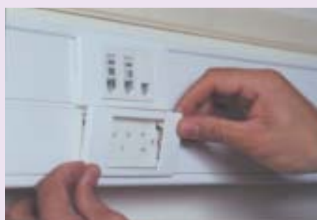
Colocação das placas
