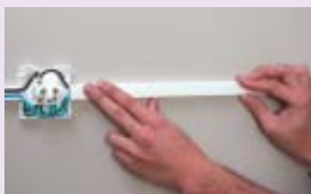
Medir, cortar e encaixar a tampa da canaleta
