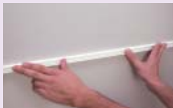
Definir o ponto, medir e cortar a base da canaleta e fixá-la na parede
