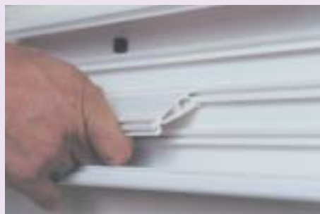
Instalação do separador que permite a divisão da canaleta em dois compartimentos
