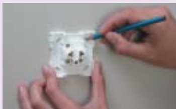
Definir o ponto, marcar, fazer a furação e fixar o mecanismo
